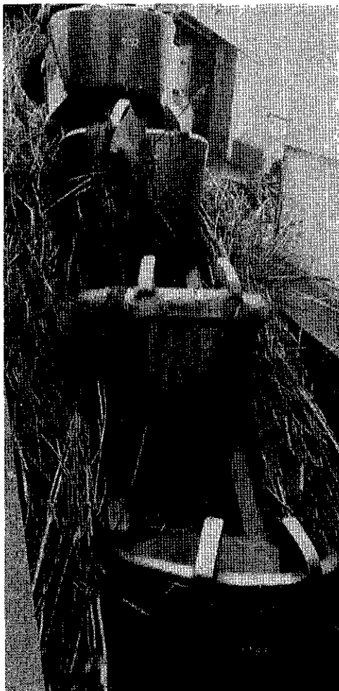
Samen met veel zand worden de resten van de bodembescherming met bakken afgevoerd
