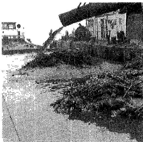
Samen met veel zand worden de resten van de bodembescherming met bakken afgevoerd
